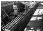
グリッドメタル設置
