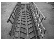
部材に合わせて工場で曲げ加工
