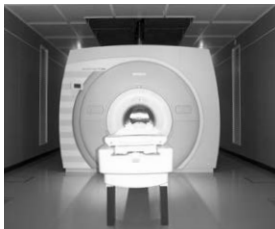
7T-MRI 完成写真 (磁気、電波シールド施行済み)
