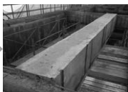
ポリマーセメントモルタル吹付け完了
